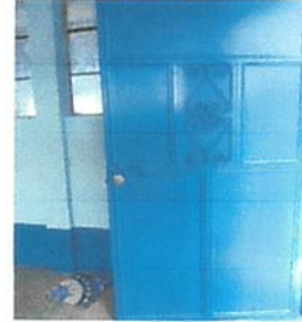
Foto 4: mantenimiento de puerta
