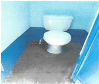
Foto 5: sustitución de inodoros
