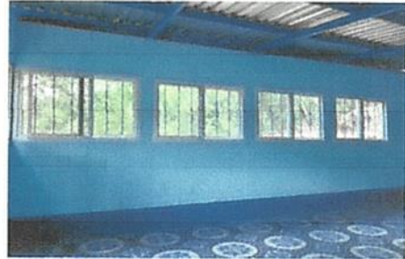
Foto 2: suministros e instalación de ventanas
