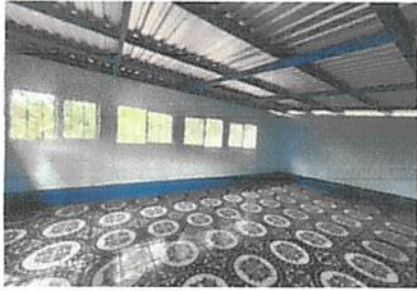
Foto 3: sustitución de piso de torta por piso ceramico
